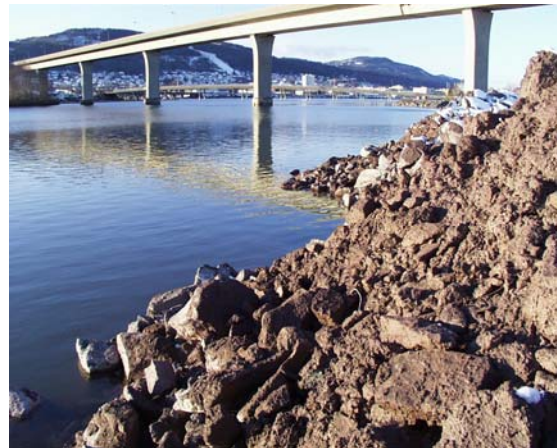
Park 1 nedstrøms E18 bru
