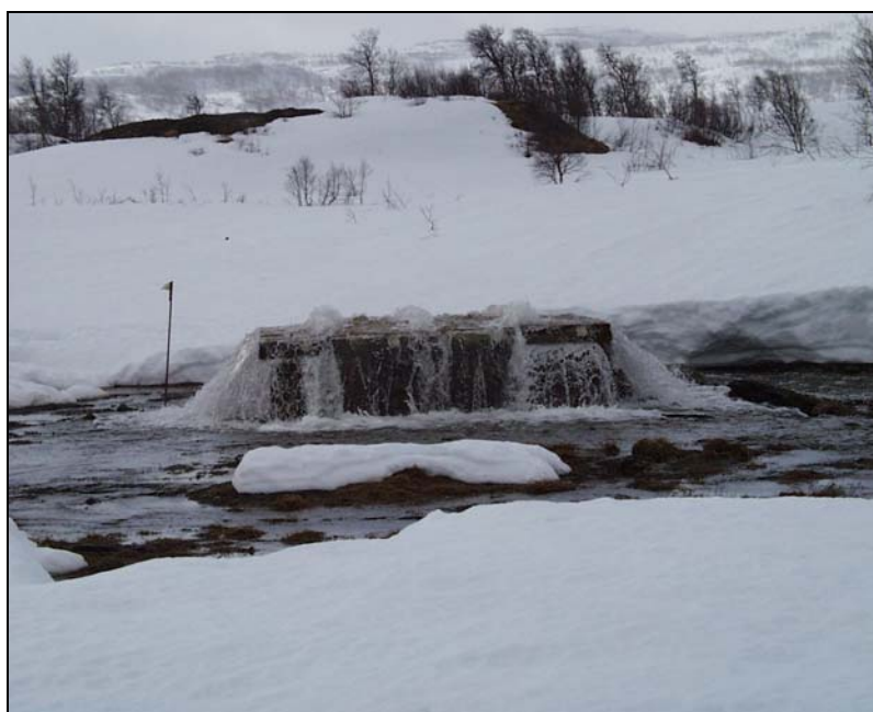
Figur 6. Overløp ved stigort 4 under vårfloppen. Bildet er tatt 5. mai 2000. Vannføring ca. 900 l/s.
