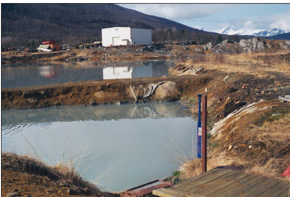
Figur 1. Klaredam for avslamning av gruvevann
