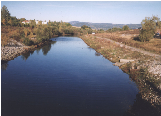
Figur 3.6 Vestfosselva rett nedenfor Vestfossen ved 20 \text{ m}^3/\text{s} , ved 6 \text{ m}^3/\text{s} og ved 1.5 \text{ m}^3/\text{s} (14/10-99). Ved å betrakte røret på høyre side av elva, får man et inntrykk av de ulike vannstander.
