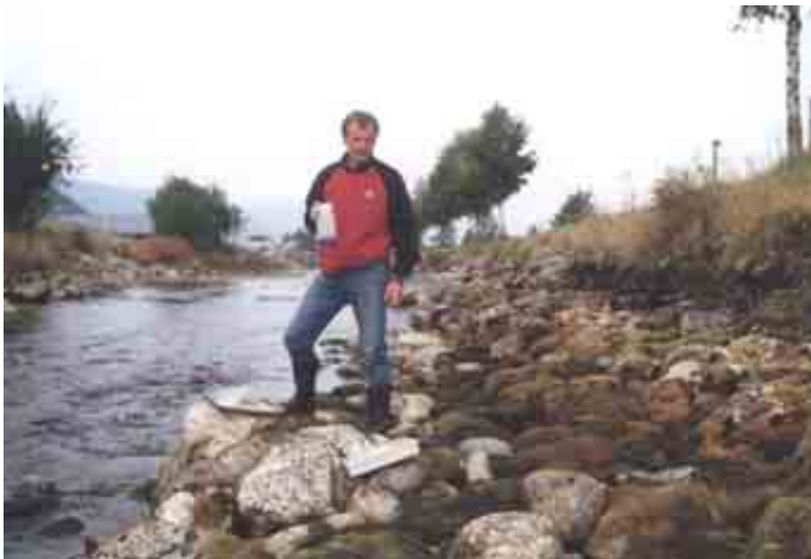
Figur 3.11 Nedre stasjon i Vikja (V1). Lav vannføring som følge av rep.arbeid ved Høve kraftverk. Vikja har stedvis betydelig mosebegrøing. Forøvrig gir elva et lite forurenset inntrykk.
