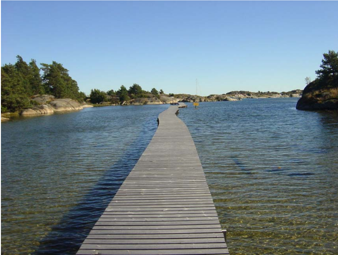
Figur 3. Elektrodeanlegget i Grosøysøyla. Elektrodene er gravd ned i sedimenet under brygga på bilde. Elektrodeanlegget ses mot sørøst. (Foto:Lise Tveiten, NIVA)
