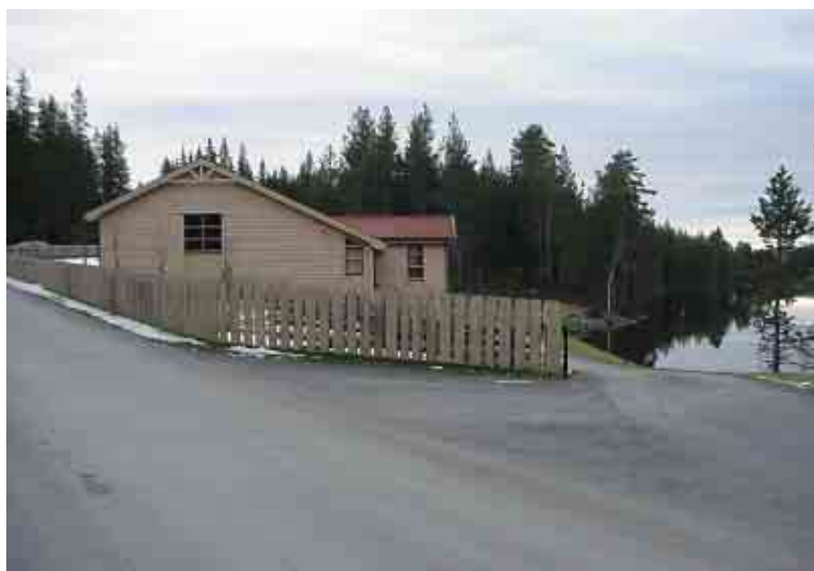
Skjelbreia Vannverk i Vestre Toten kommune
