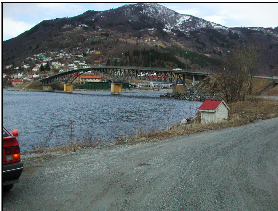
Figur 2. Loftesnesbrua, april 2003. Øvst: Sett frå Sogndals-sida. Nedst: Sett frå innfartsvegen på austsida (Loftenes-sida).
