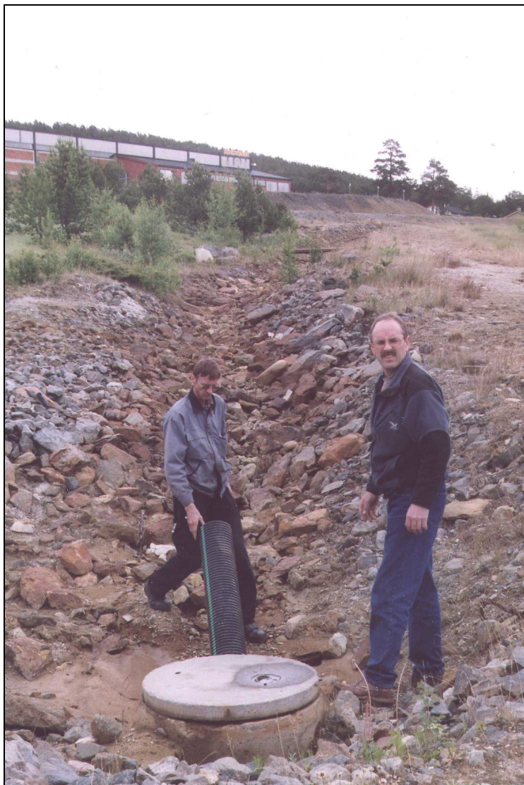
Figur 7. Drensgrøft mellom Sagvegen og industribygget til Norø.
