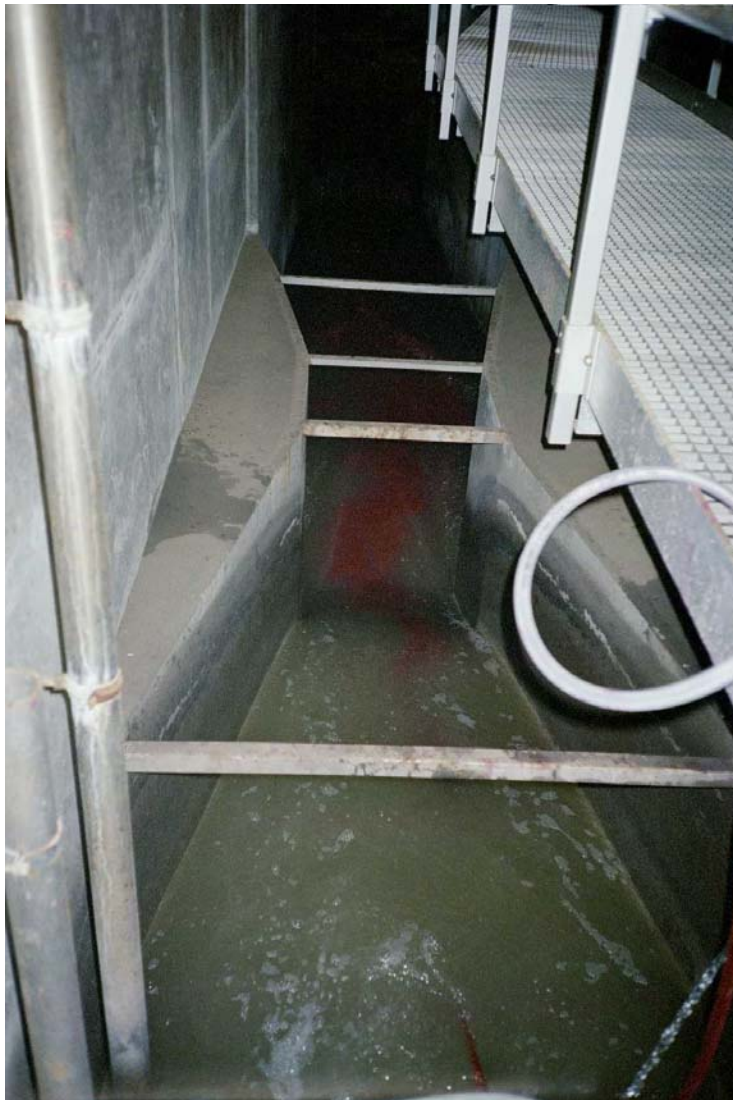
Figur 7. Dosering av sportstoff i utløpsrenna (Parshallrenna) ved Ytre Sandviken RA (raudfargen kan skimtast nederst i renna).
