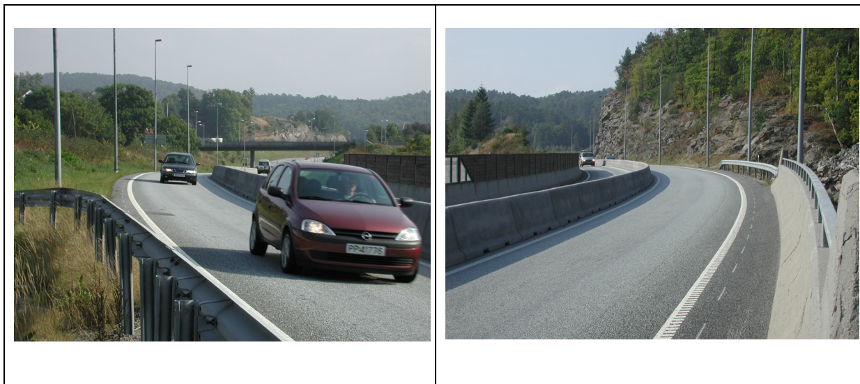
Utsnitt av veibane og omkringliggende nedbørfelt til E18 ved Hånesbukta
