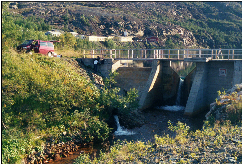
Figur 11. Utløpet av Dausjøen (stasjon B3). Drensrøret fra Grubebekken/Oterbekken kommer inn fra venstre nedenfor dammen.
