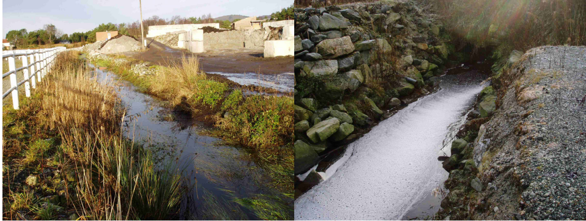
Bilde 3: Bekk fra Travparken. Til venstre litt av anlegget for sortering av jord og stein langs bekken. Til høyre utløpet av rør under travbanen. 12.11.03. Foto: A.Hobæk.
