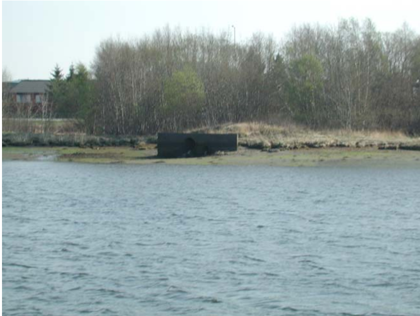
Figur 11. Oversiktsbilde fra området rundt Søndre kulvert for utløp av overvann fra rollebane og flyoppstillingsområde.
