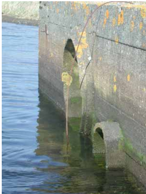
Figur 12. Nærbilde av Søndre kulvert med begroing.
