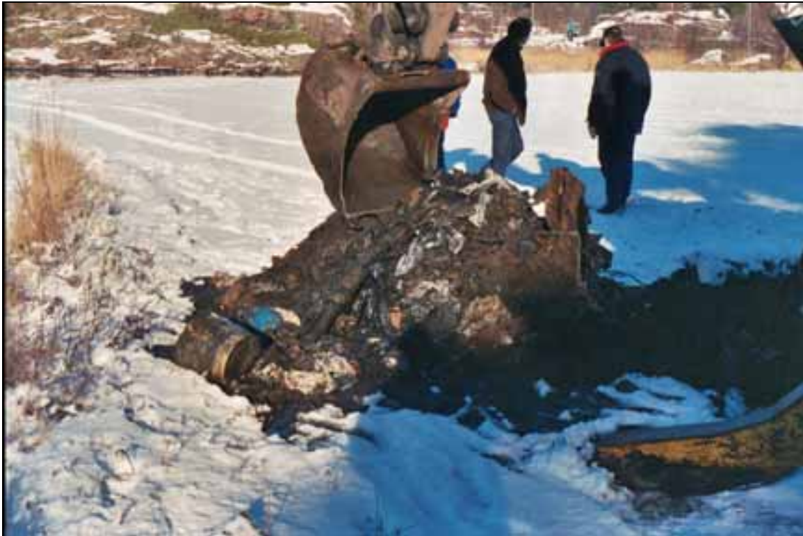
Figur 2. Graving av prøvesjakt i utkanten av Hesnes deponi 12.02.2004. Foto: Eigil Iversen
