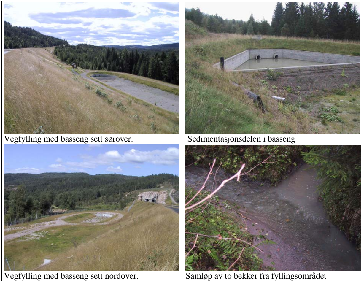
Figur 2. Fylling, basseng og samløp mellom to bekker fra fyllingsområdet.
