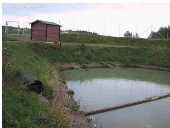
Sommer 2002, målebu, innløpsrør, terskel, overløpsrør. Tidlig vår 2003, fra innløp
