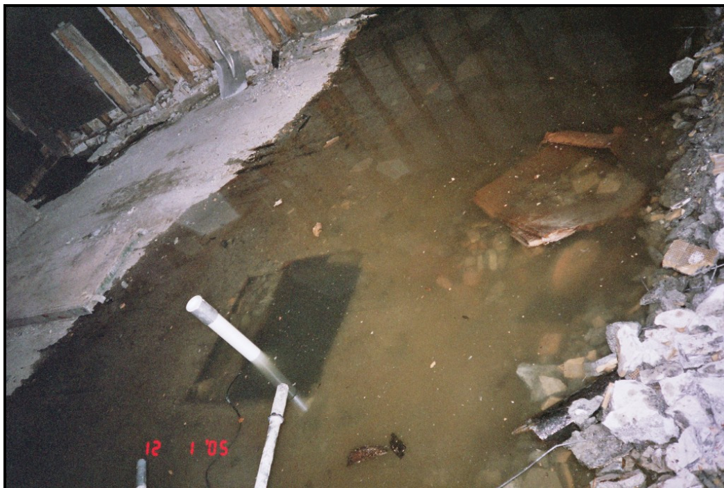
Figur 8. Frå fiskebutikken under springfloa 12. januar 2005. Vannstandsmålaren (sensoren) blei etter dette plassert ned i målebrønnen (brønn MB9). Manuell måling av salinitet blei også gjort i denne brønnen i perioden 10. mars – 29. april 2005.
