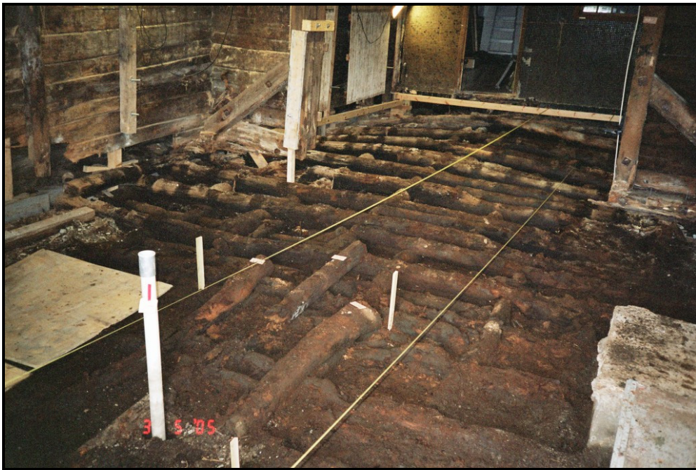
Figur 3. Rehabilitering av skadd bolverk i fiskebutikken, mai 2005. Opprinneleg tregolv og betong/fliser på toppen er fjerna. Brønn MB9 i forgrunnen.
