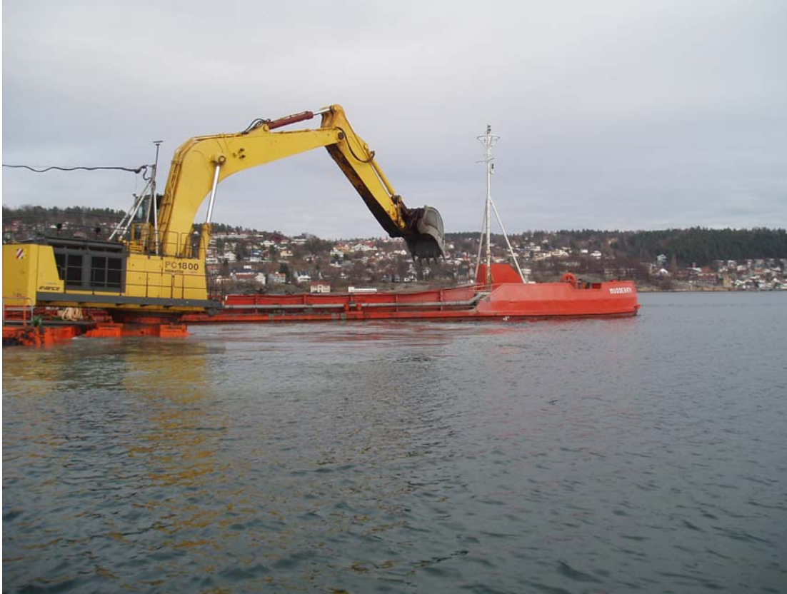
Figur 1. Graving i Drøbaksundet ved Småskjær 14/04-05 med "Transport 052" og lekeren "Mudder O79"
