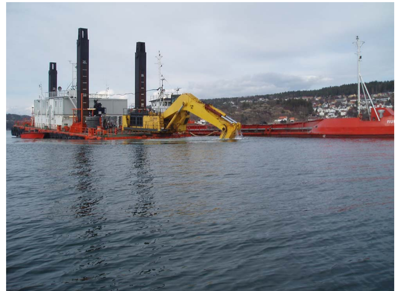
Bildet viser graving av leirholdige masser ved Småskjær 14/04-05 med den kombinerte grave og transportlekteren "Transport 052" og splittlekteren "Mudder-079". Foto: John Arthur Berge.
