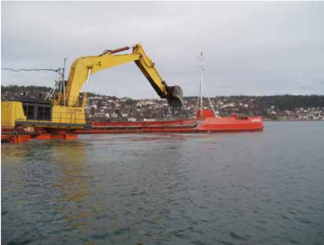
Figur 1. Graving i Drøbaksundet ved Småskjær 14/04-05 med "Transport 052" og lekeren "Mudder 079"
