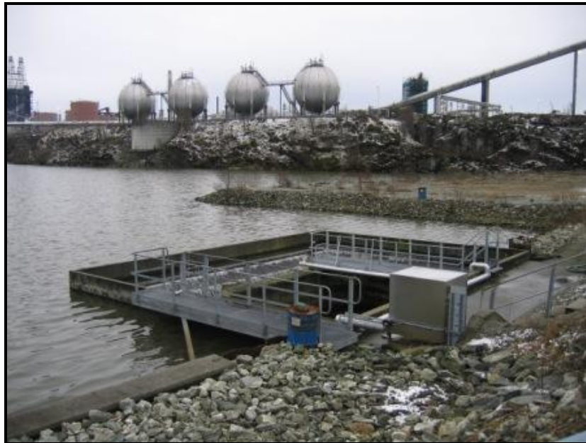
Figur 6. Foto av utløpskummen i nedre del av sikringsbassenget.
