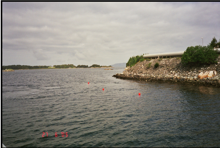
Figur 9. Omådet inne ved land der det var lekkasje på avløpsrøyret.
