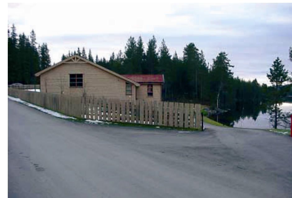
Skjelbreia Vannverk i Vestre Toten kommune Etablert i 1998.
