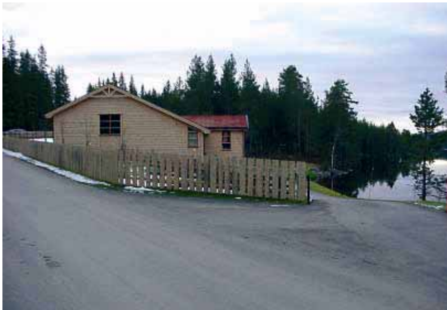
Skjelbreia Vannverk i Vestre Toten kommune Etablert i 1998.
