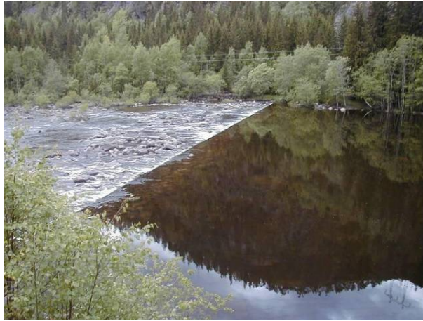
Figur 14. Bildet til venstre viser gammel spuntterskel ved Skjønne, mens bildet til høyre viser gammel kjøreterskel ved Hvammen. Begge foto: Numedals-Laugens Brugseierforening.
