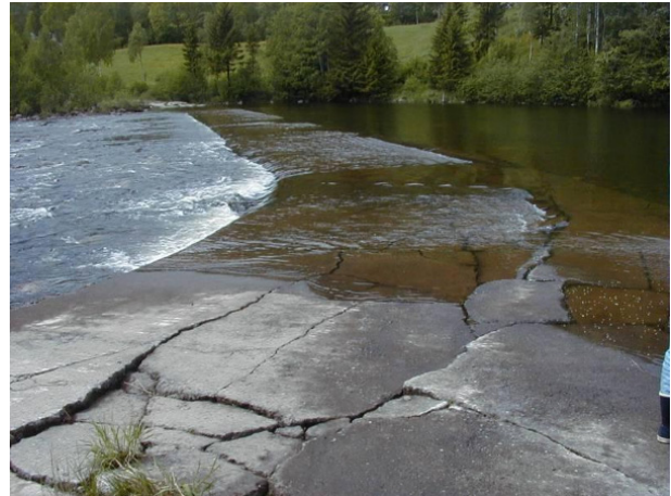
Figur 14. Bildet til venstre viser gammel spuntterskel ved Skjønne, mens bildet til høyre viser gammel kjøreterskel ved Hvammen. Begge foto: Numedals-Laugens Brugseierforening.
