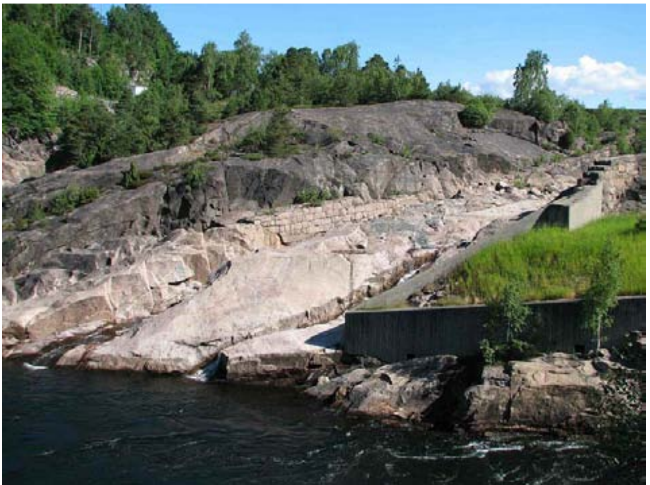
Bilde over området for mulig plassering av laksetrapp i Vigelandsfossen
