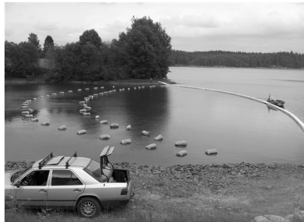
Sekkene med halm legges ut. Disse sank etter hvert slik at bare isopor klossen ble hengende i overflaten
