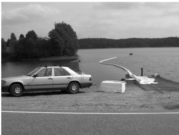
Isoporblokker (flotør) tres i mens duken trekkes ut med båt
