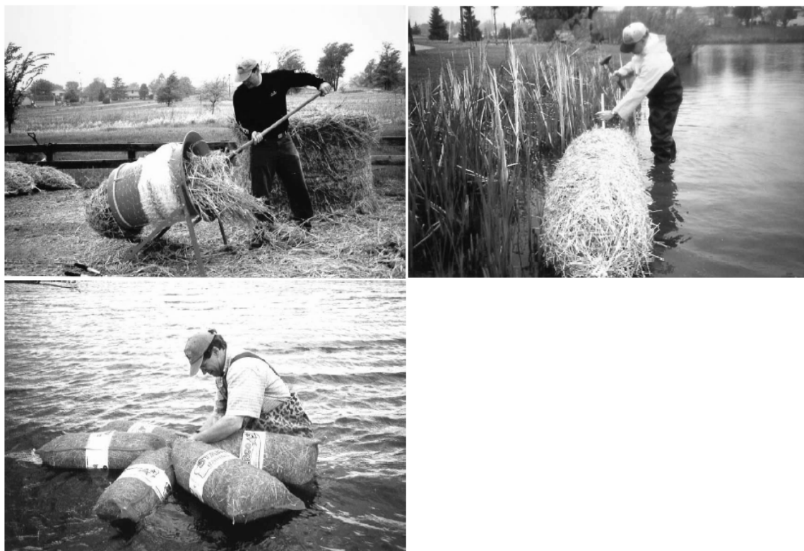
Figur 1. Øverst til venstre. Løst pakkede halmpølser lages ved hjelp av en juletre-pakker. Legg inn en isoporbit med jevne mellomrom. Øverst til høyre: Halmpølse legges ut. Nederst: Løst pakkede vedsekker. Foto: CAMP (Center for Aquatic Plant Management, England)
