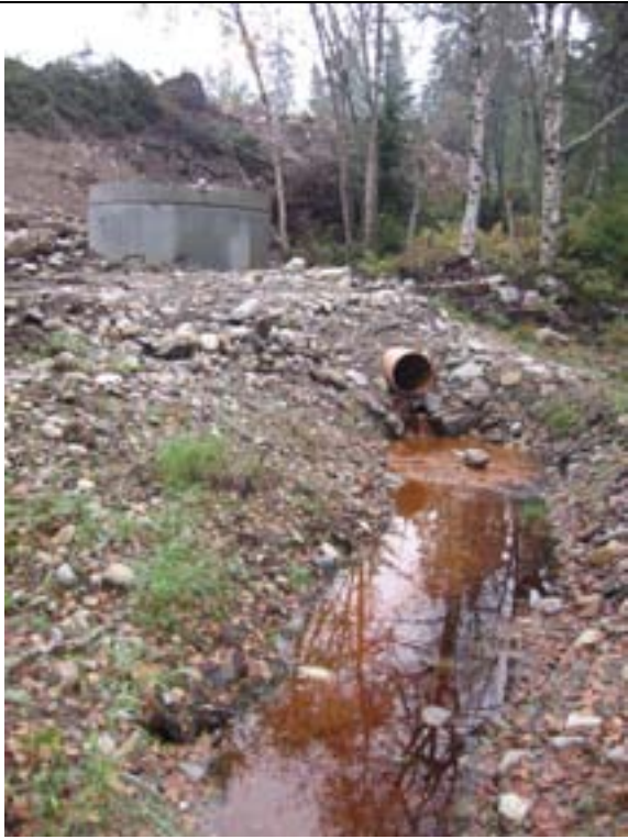
Figur 4. Restutslipp til Bjørnbekken ved Budor 26.9.
