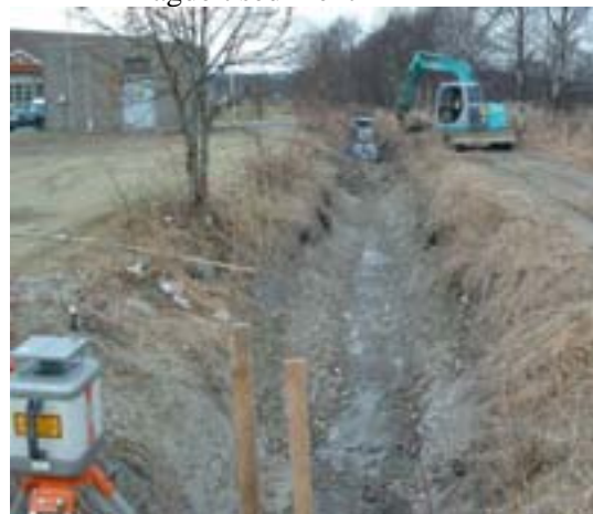
Restaurering av bekken
