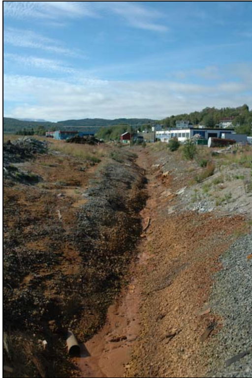
Figur 17. Sigevann ved kanten av deponiet "Bakeribekken" den 15.8.2006. Foto: Eigil Iversen, NIVA
