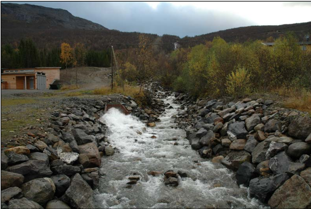
Figur 2. Arneselva ved E6 nedenfor tilløp av kraftverket. Foto: Eigil Iversen, NIVA
