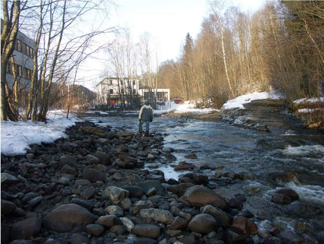
Figur 17. Øverste terskel forankres mot fjellutspringet på nordøst siden av elva. Nederste terskel forankres mot fjell nedstrøms utløpet av sidebekken fra øst
