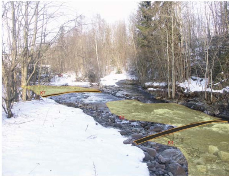
Plassering av terskler ved Smedhølen
