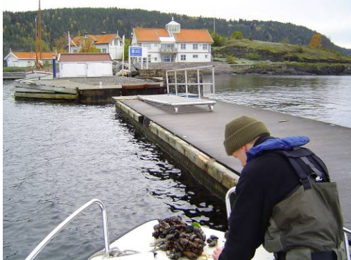
Brygge på nordsiden av Persteilene ytterst
