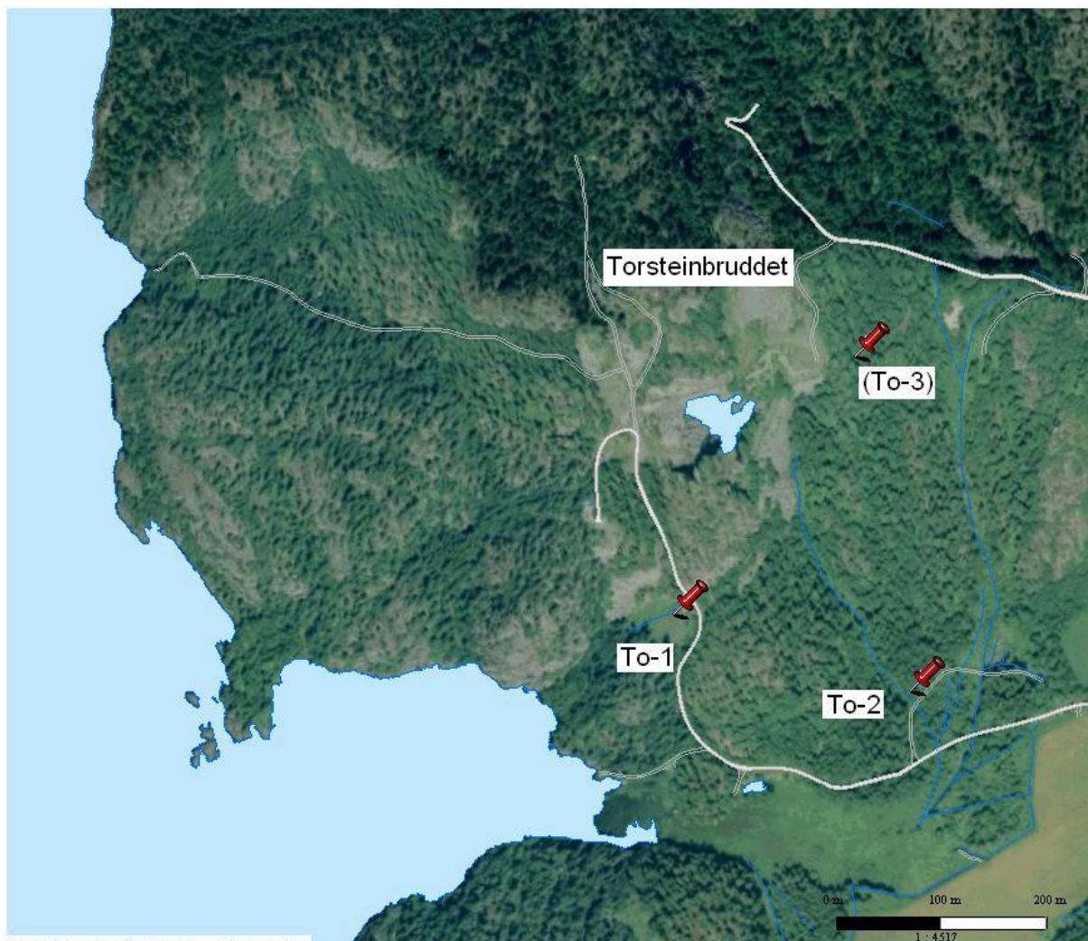
Figur 3. Flyfoto over Torsteinbruddet avsluttet for 18 år siden (1988). Prøvetakingsstasjoner er innlagt.
