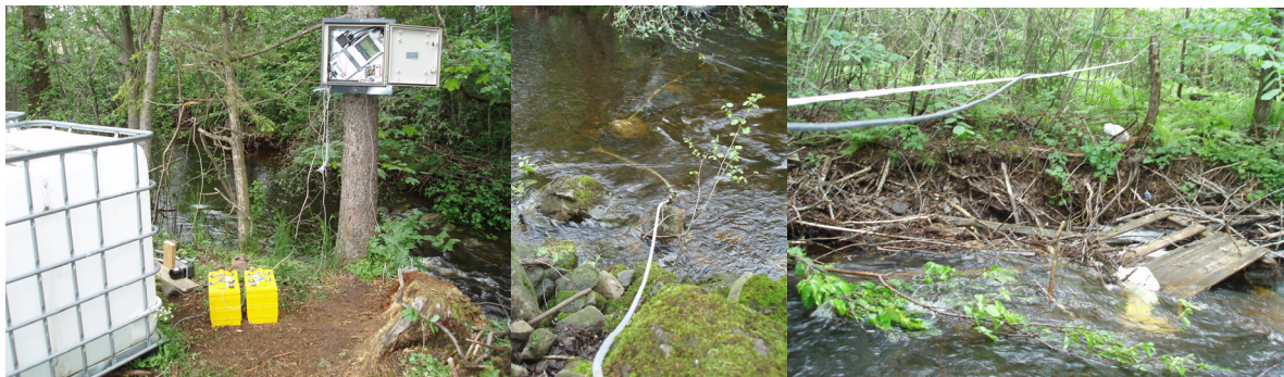
Figur 12. Fra forsøkene i Vesleelv våren 2007; ALS-tank, doseringspumpe (festet til en provisorisk rigg av treverk) og elektroskap til venstre. Nedsenket doseringsslange med flere dysehull for god spredning av ALS i midten og pH-målepunkt med kabelstreck over elva til høyre. Bildene er tatt under flom.
