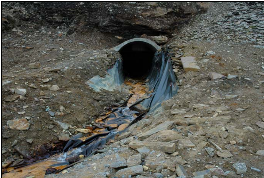
Figur 17. Overløp Jakobsbakken gruve gjennom Nils stoll den 17.9.2008. Foto: E.R. Iversen.
