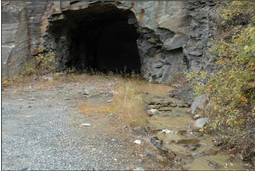
Figur 16. Gruvevann fra Rupsi stoll den 17.9.2008. Foto E.R. Iversen.
