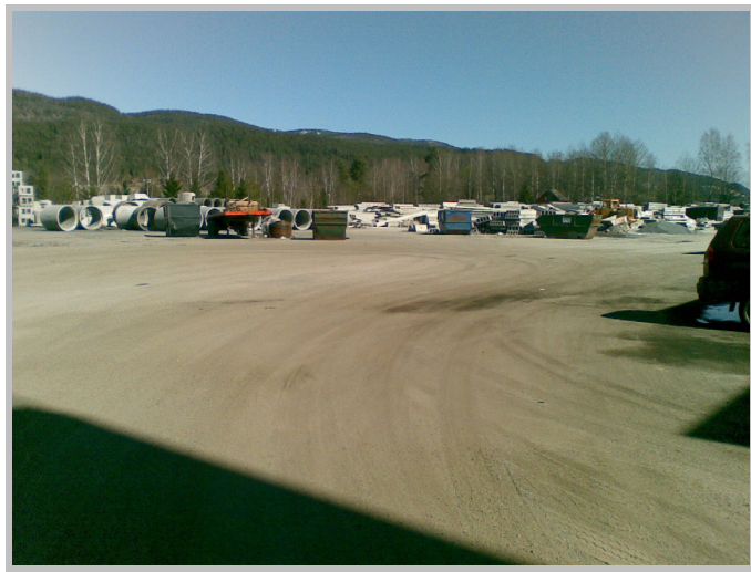
Figur 5. Asfaltert lagerområde for betongelementer. Det er betydelig trafikk av lastebiler og maskiner på området og betongbiter som skalles av de nystøpte produktene blir knust til kalkrik sand og "søle" (ses tydelig på bildet) som vaskes ned i overvannssystemet, bl.a. ved regnvær.
