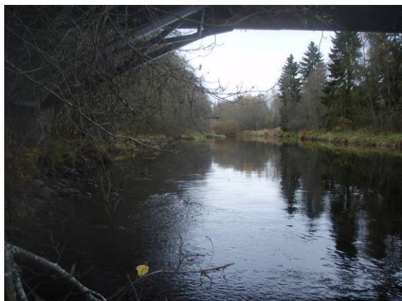
Svartelva sett oppstrøms stasjonen
