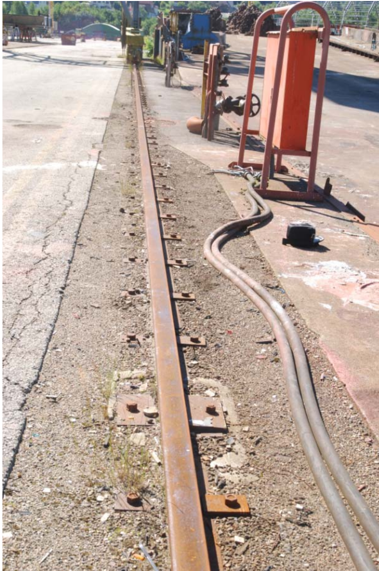
Bilde 1. Stasjon AV1. Prøven tatt der hvor slangen gjør en buktning inn mot skinnegangen.
