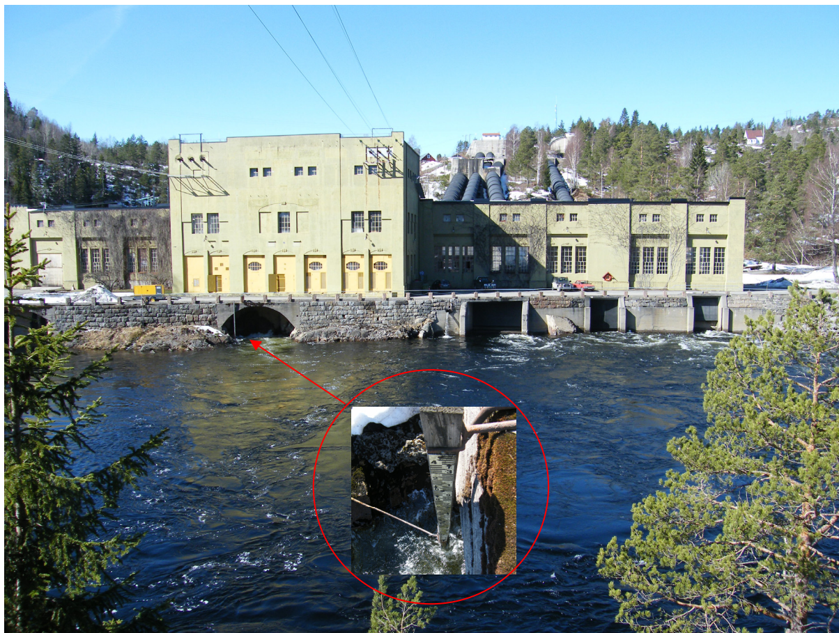
Figur 10. Foto av Bøylefoss kraftstasjon med avmerking av vannstandsstaven. På bildet vises også de fire utløpene fra åtte generatorer på kraftstasjonen. Ikke alle er nødvendigvis i drift samtidig. Derfor må installasjon(e) for nøddosering fra bil monteres slik at kalk alltid blir dosert inn i fossende vann selv om noen av utløpene er uvirksomme.
