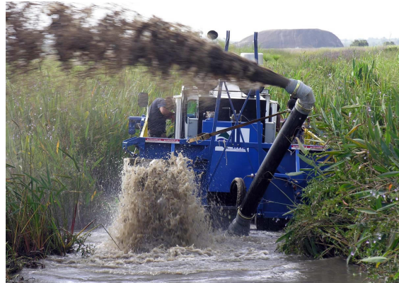
2. Materialet kan sprutes på land som en snøfreser, eller pumpes på land eller til en avvanningslekker.
