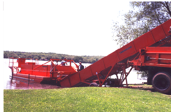
4. Lekteren tømmes over på et nytt transportbånd som lesser materialet opp i en lastebil.
