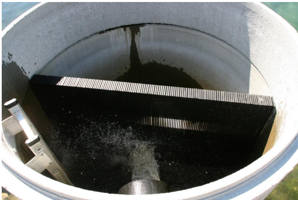
Figur 5. Akvarist som sekundærsikring på hovedavløp
