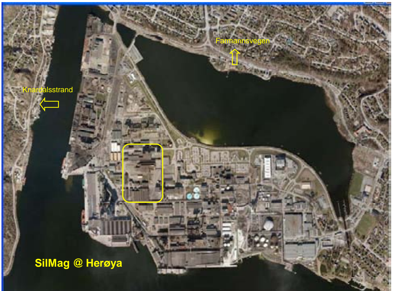
Figur 1 Flyfoto av Herøya som viser plasseringen av den nye fabrikk markert med gult
