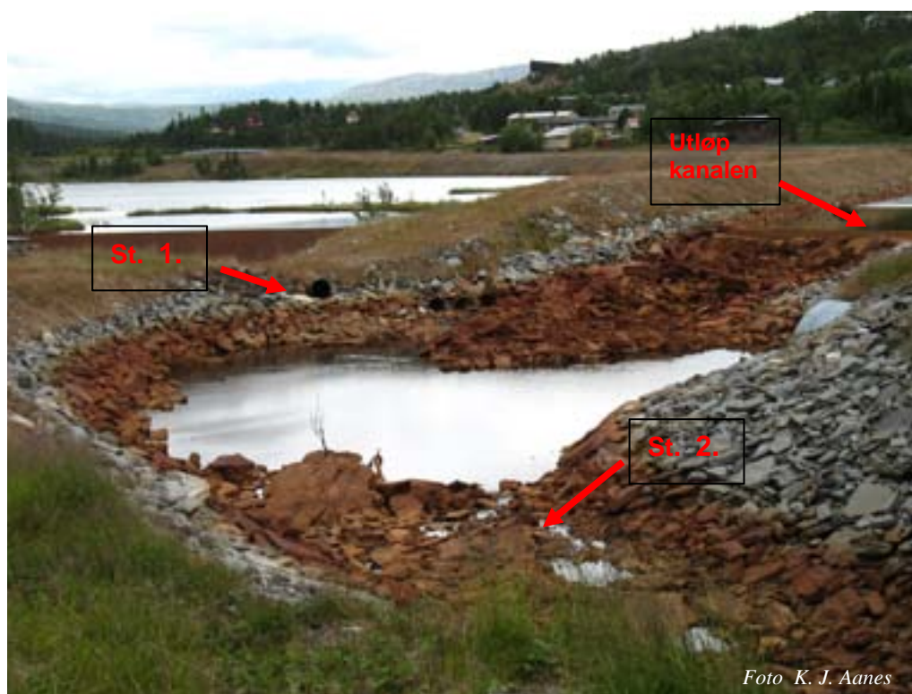
Foto 23. juli 2009. Bildet viser starten på Bleikvasselva med samløpet mellom utløpet fra Lille Bleikvann (nedre avgangsdam) og avløpet fra nedre terskal på kanalen fra Kjøkkenbukta.
