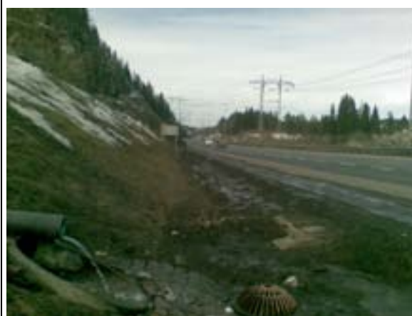
Overløpsrør i vegkanten
