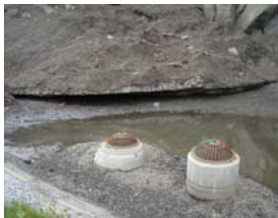
Kummer i renseanlegget
