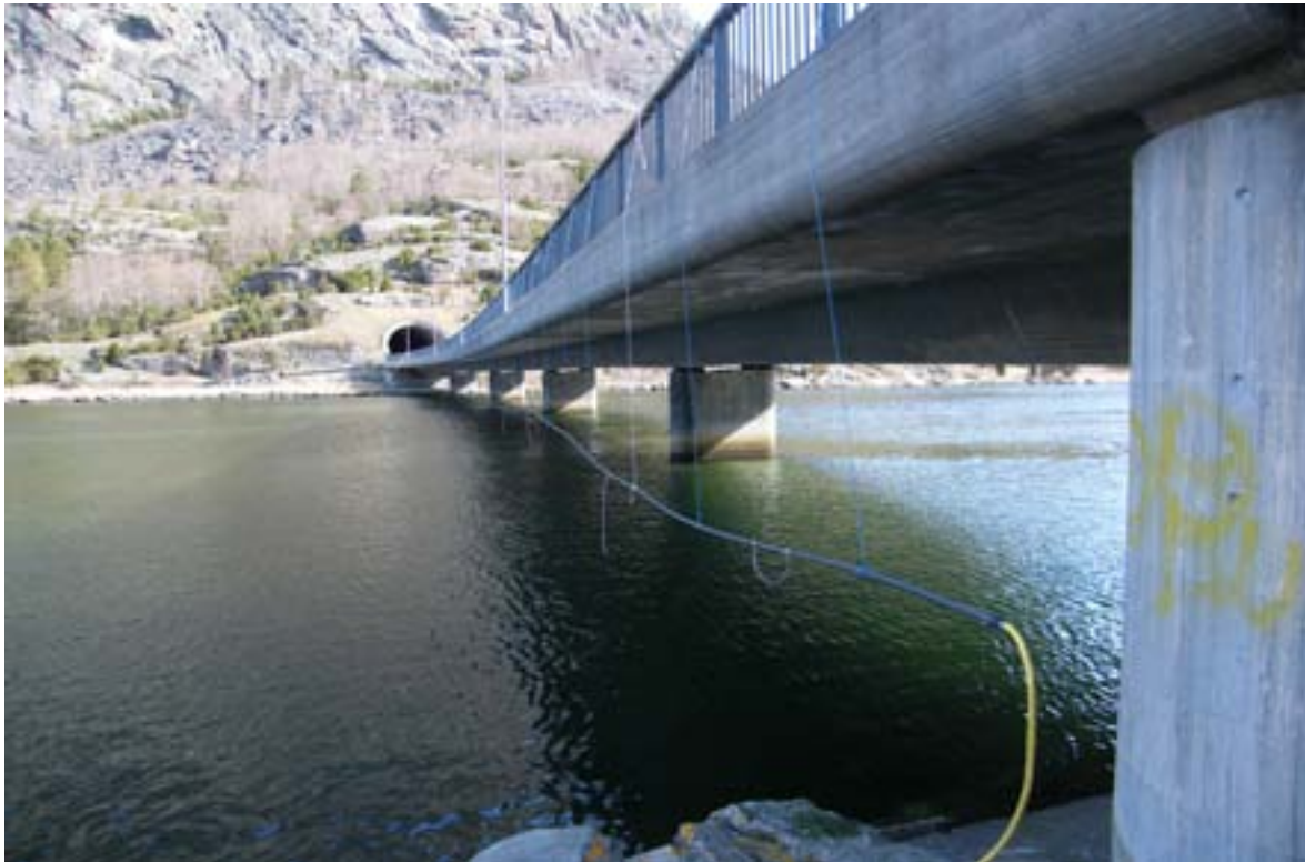
Figur 4. Distribusjonssystemet ved Helle bru på riksvei 5 under behandlingen i 2008. Denne var ikke i bruk i 2009, men tilsvarende system ble brukt på alle doseringsstasjoner i hovedelv. Foto: Rolf Høgberget
