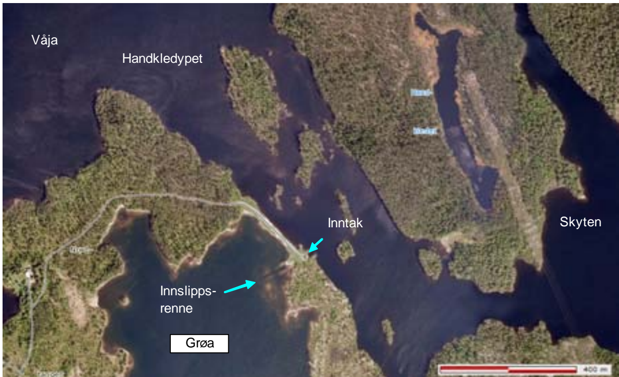
Figur 14. Vannet tas inn på ca 2 m rett utenfor lukehuset og slippes ut i en gravd renne rett på innsiden av demningen.
