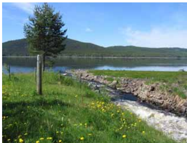
Utløpet fra Tyria kraftstasjon 17.6.2010
