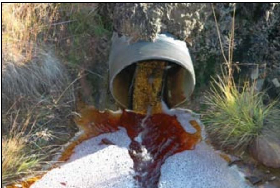
Figur 9. Stasjon 2A – Utløp rør for samlet avrenning fra Folldal sentrum ved RV 29.
