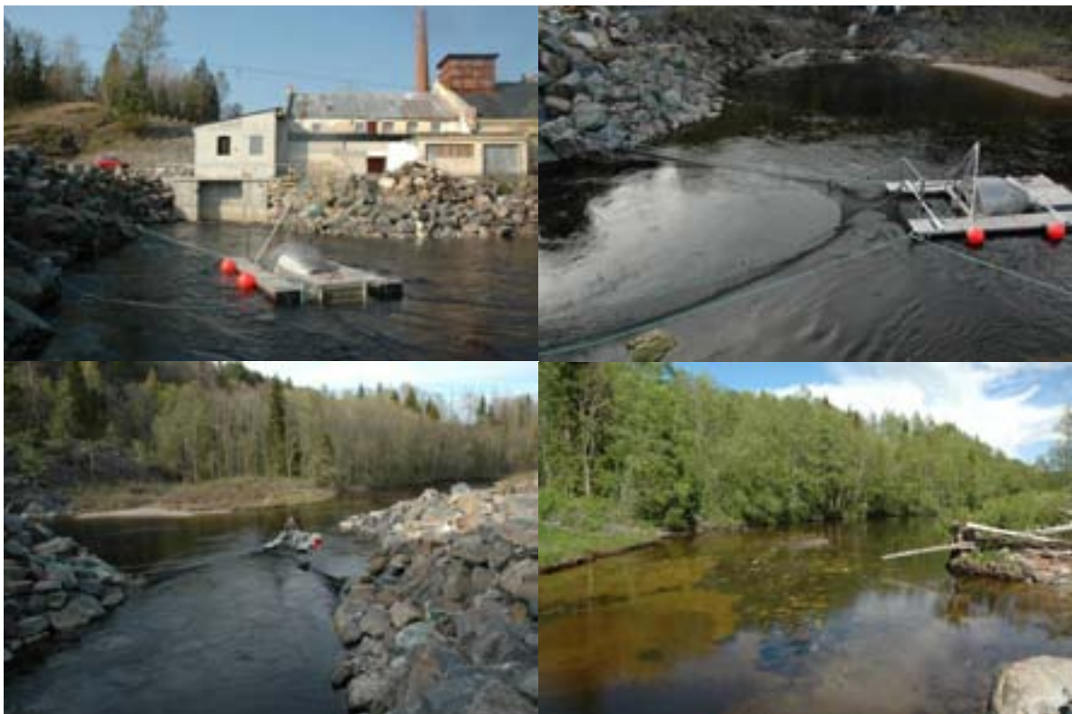
Figur 8. Bilder tatt av smoltfella nedstrøms kraftverket (øverst venstre), av smoltfella med ledegarn (øverst høyre), av fella hvor minstevannføringsløpet forbi kraftverket kommer inn fra venstre (nederst venstre) og av Storelva etter samløpet (nederst høyre).
