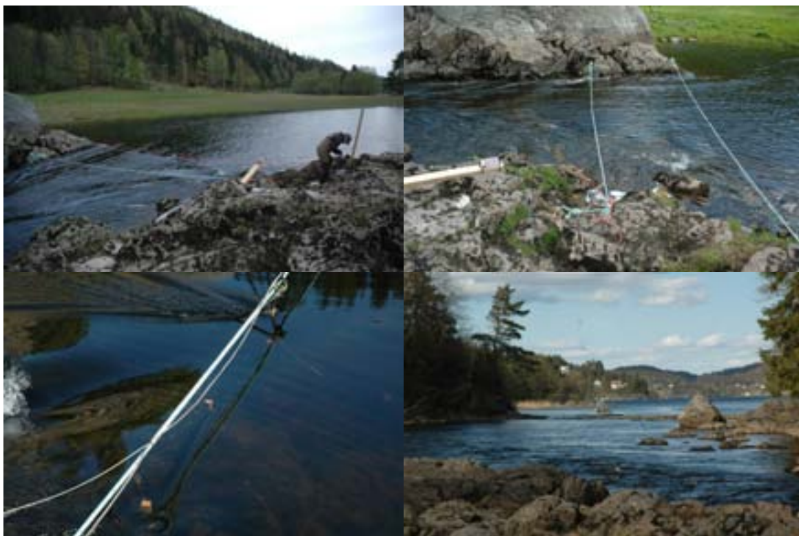
Figur 12. Øverst til venstre og høyre: PIT-antenna ved stasjon 1870. Nederst til venstre er deler av antenna vist i detalj (bl.a. treplugger benyttet til å feste antennen til elvebunnen). Nederst til høyre skimtes smoltfella nedstrøms PIT-antenna.
