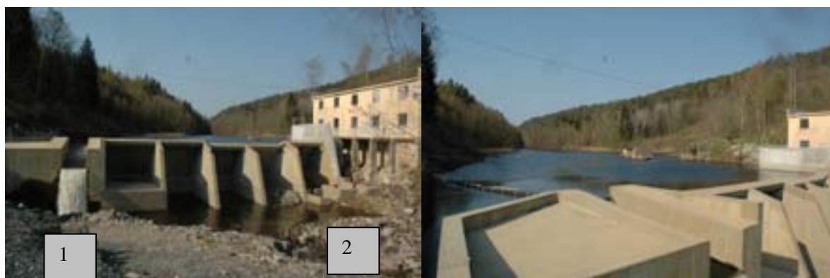
Figur 9. Illustrasjon av kraftverksdam (venstre) og plassering av sperrenot (høyre). Nota er trukket fra damkrona til åskanten bakenfor. Mens nota var operativ gikk det vann i rensekanal samt i laksetrappa. Disse stedene er antydnet med tallene 1 og 2.
